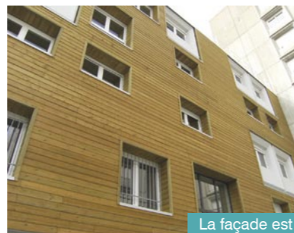
La maison Rossini intégrée dans le quartier
